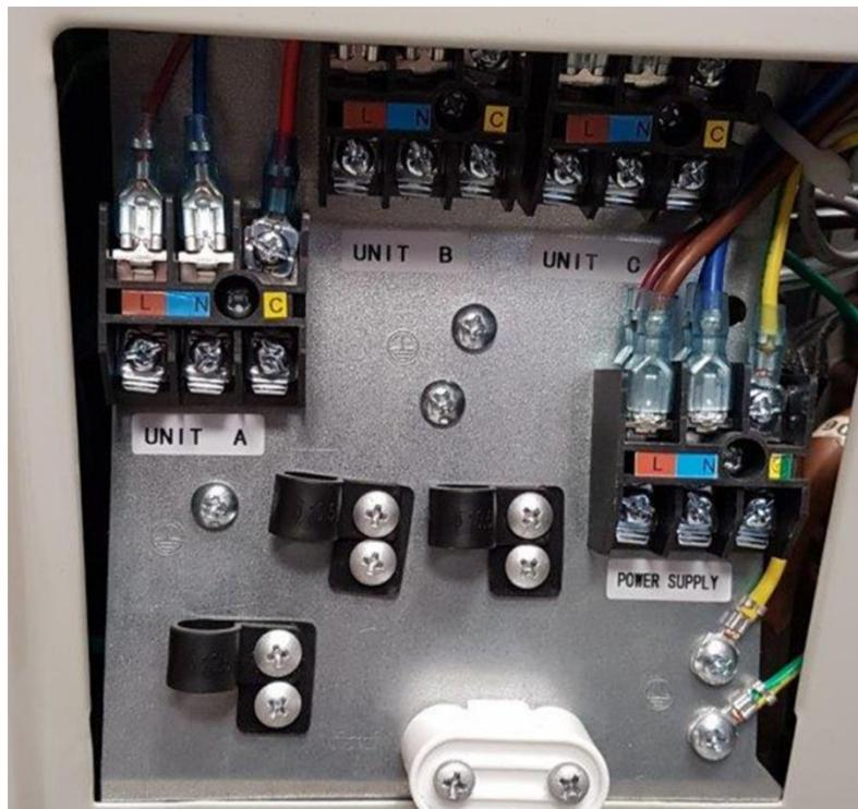
Exemple de câblage des unités murales ou consoles avec une pompe de relevage
