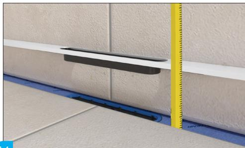
14 Diepte opmeten om het rooster de nodige ondersteuning te voorzien aan de hand van roosterblokjes./ La profondeur doit ensuite être mesurée afin de fournir le support nécessaire à l'aide des blocs appropriés./Anschließend muss die Tiefe gemessen werden, um mit den entsprechenden Blöcken die nötige Unterstützung zu bieten./Measure the depth to provide the grating with the necessary support using grafting blocks.
