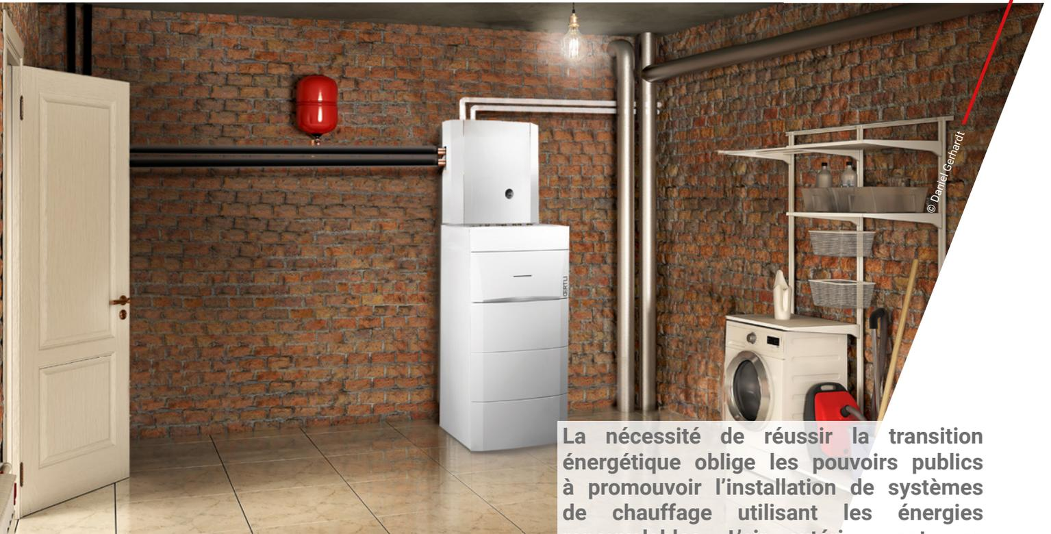
La nécessité de réussir la transition énergétique oblige les pouvoirs publics à promouvoir l'installation de systèmes de chauffage utilisant les énergies renouvelables. L'air extérieur est une énergie renouvelable par excellence. Et le meilleur moyen d'en extraire les calories est l'utilisation d'une pompe à chaleur (PAC) qui va « pomper » la chaleur grâce à un cycle thermodynamique fermé d'un gaz appelé fluide frigorigène pour les restituer à l'eau de chauffage.
