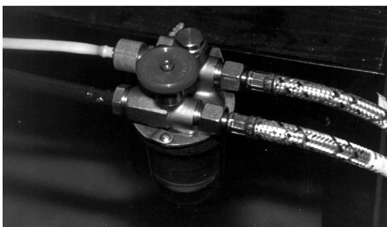
Dabei wird die Pumpe im Zweistrangbetrieb belassen. Vor- und Rücklauf-Brennerschläuche am Filter montieren. Ölhahn am Filter öffnen. Anlage in Betrieb nehmen.
