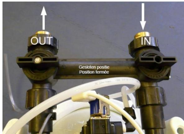
Monteer de bypass zoals aangegeven op de foto. Let op de stand van de 2 afsluitkranen. De positie zoals op de foto is de "gesloten" positie. Laat deze afsluitkranen in de gesloten positie. De technicus zal deze kranen voor het eerst openen tijdens de inbedrijfstelling van het toestel.
