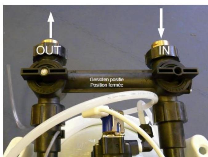
Montez le bypass comme démontré sur la photo. Tenez compte de la position des 2 robinets de fermeture. La position sur la photo est la position fermée. Laissez les robinets de fermeture en position fermée. Le technicien les ouvrera pendant la mise en service de l'appareil.
