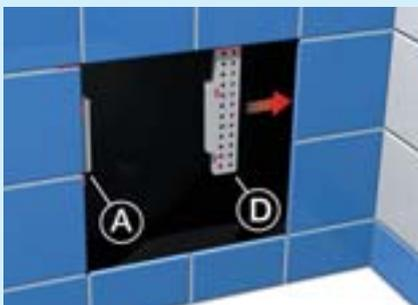
Par l'ouverture, positionner suivant les pattes de guidage et coller les pièces de dormant A et D
