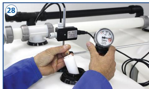
Inhaltsanzeiger mit aufgeclipster Tankskala montieren (Schwimmer langsam ablassen).
