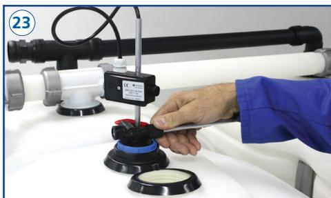
Überwurfmuttern an beiden Enden der Verbindungsleitung fest an die Entnahmemarmaturen anschrauben.
