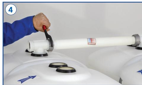
Alle Verschraubungen der Füllleitung mit Hilfe eines Kupplungsschlüssels (95-110) anziehen.
