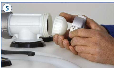
Ende der Füllleitung mit der Verschlusskappe und Alu-Überwurfmutter verschließen.
