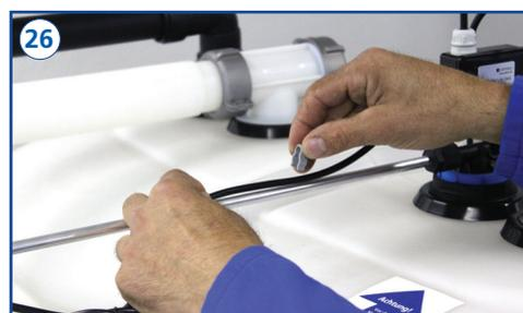
Verbindungskabel mit den beiliegenden Klammern an der Entnahmeleitung fixieren.
