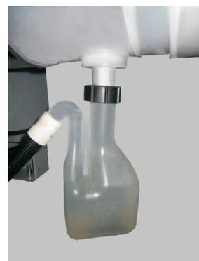
Il convient de relier les tuyaux à condensats des deux siphons du bac à condensats et de l'évacuation des condensats au moyen d'un raccord en T et de les raccorder au neutralisateur.
