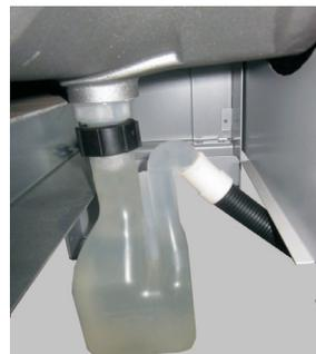
Monter le deuxième siphon au niveau des tubulures de l'évacuation des condensats
