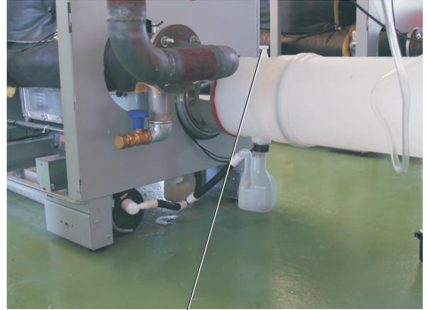
Orifice de mesure de l'évacuation des condensats
