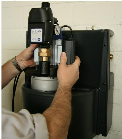
**8.4.2 Ausbau der Pumpensteuerung**
