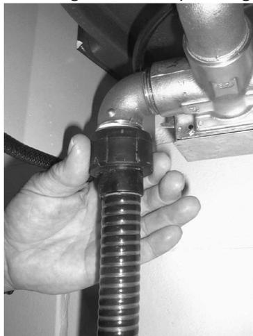
2. Am Ende des Saugrohres oder des Saugschlauches ein Rückschlagventil montieren.
