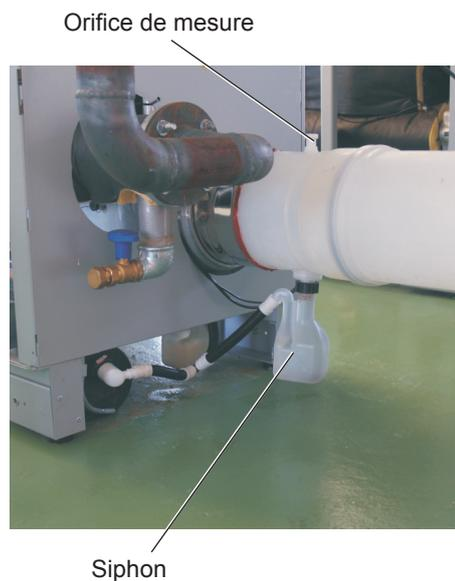
Contrôler les valeurs de l'eau et les documenter si nécessaire dans le manuel de l'installation.
