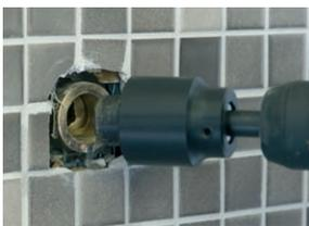
⑩ **Fraise pour extension de robinet avec logement SDS**
